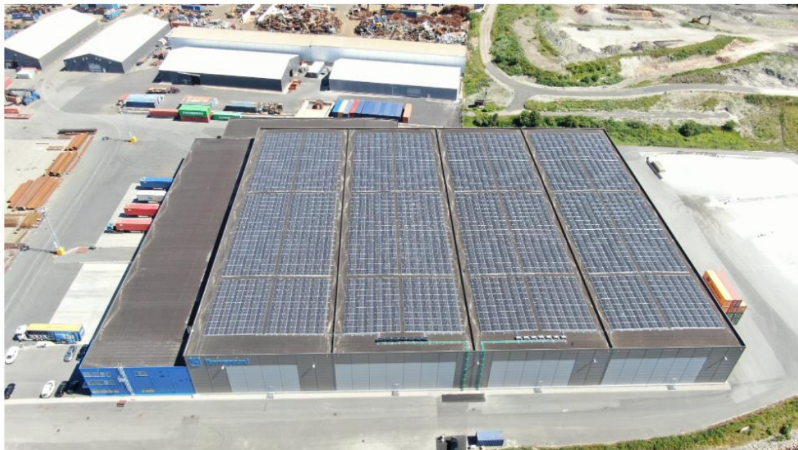
Borg Havn har lagt solceller på store deler av taket til Borregaards lager på Øra. Jobben er utført av Solcellespesialisten. Solcellene dekker over 9.600 kvadratmeter av takarealet. Foto: Borg Havn/Solcellespesialisten
