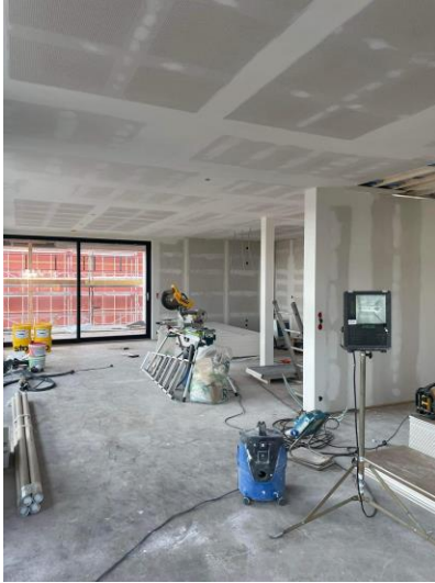
Rehabilitering og ombruk
