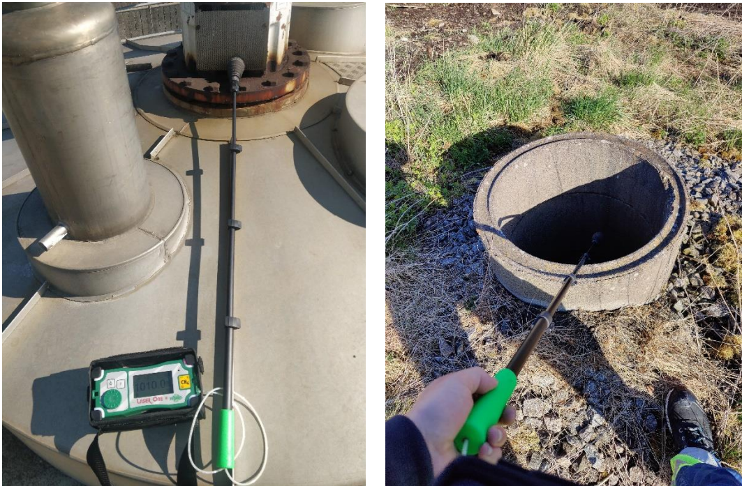
Figur 2. Måleudstyr brugt til overfladescreening (venstre). Screening ved installation (højre)
