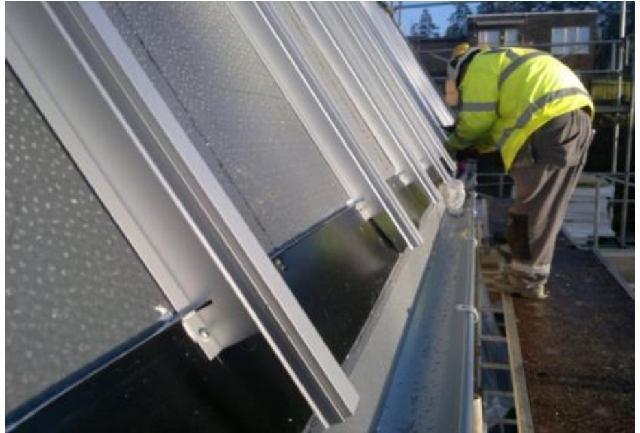
Montering av Aventa Solar (kan erstatte annen kledning på tak eller fasade)
