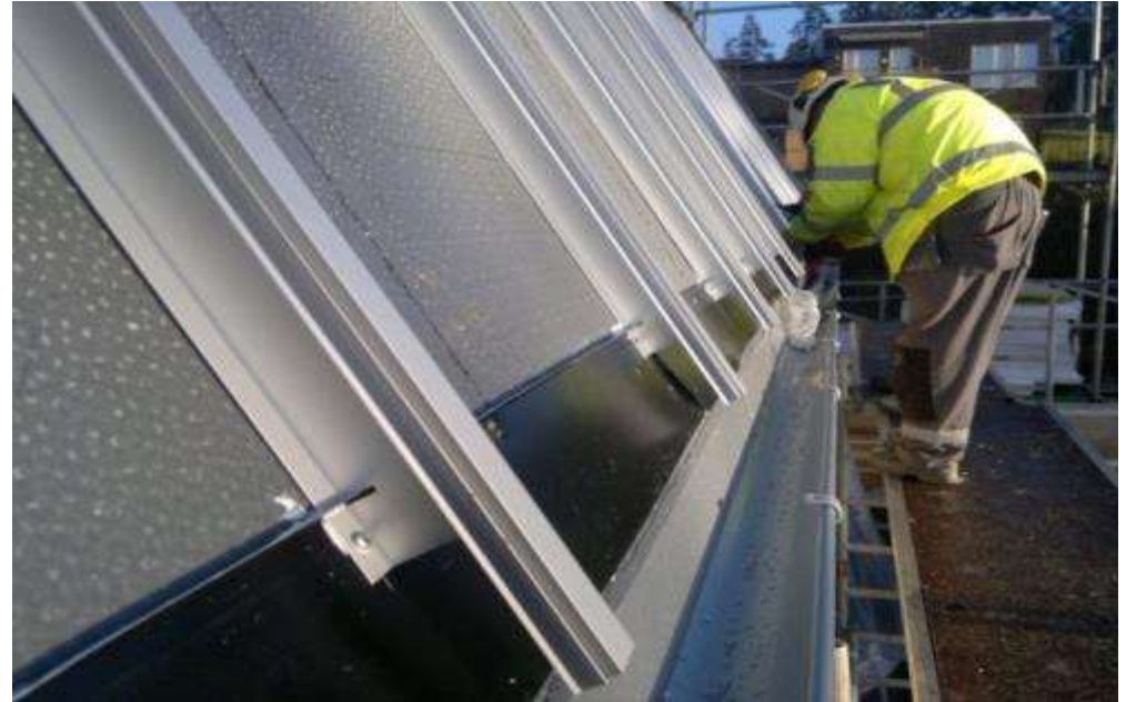
Montering av Aventa Solar (i stedet for takstein eller platetak)
