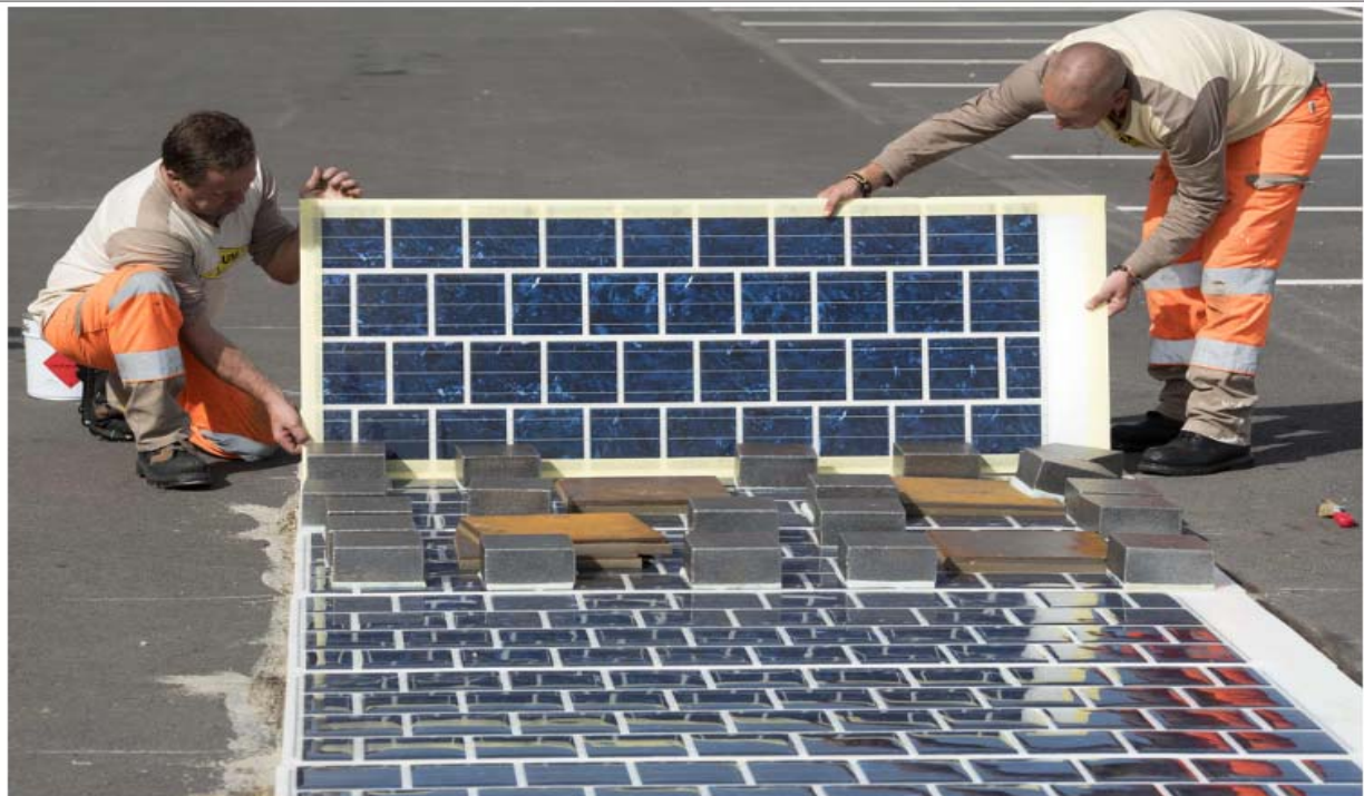
Wattways solceller produserer elektrisitet ved hjelp av en tynnfilm av polykrystallinsk silisium, bare 7 millimeter tykk. Tynnfilmene "limes" på eksisterende vei, som ikke trenger å bygges om, ifølge selskapet. (Bilde: Wattway)
